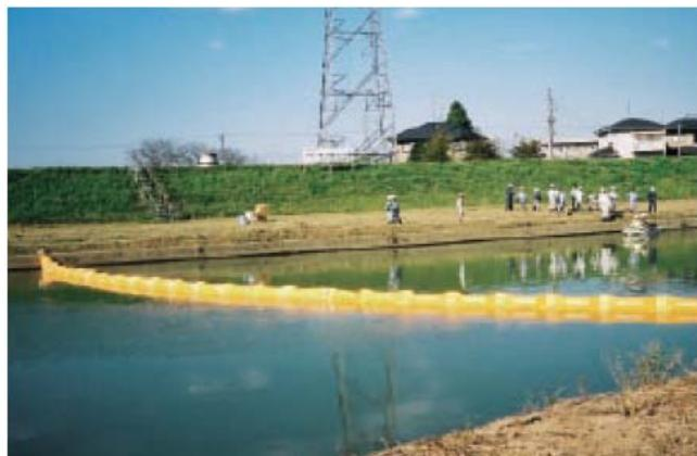
하천 등의 내수에서도 위의 가반식 오일 펜스는 이용되고 있으나, 이 이외에 확산 방지와 흡착을 동시에 실시하는 방식의 흡착형 오일 펜스를 사용할 수 있습니다.
