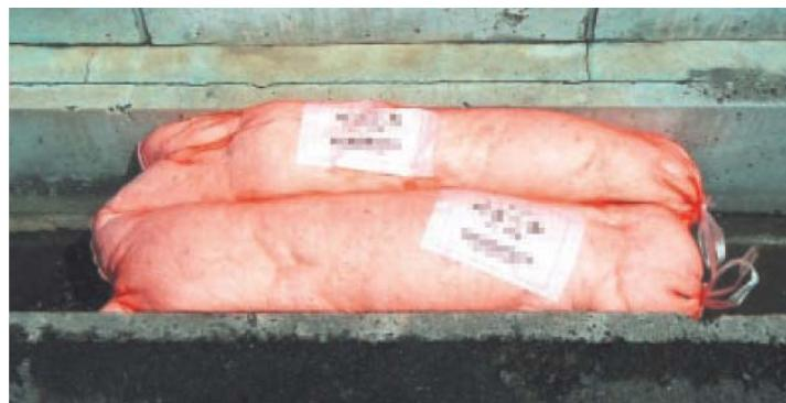
\* 유속이  $0.20\text{m/sec}$ 을 넘으면 비말 동반 누설로 기름이 밀으로 빠져나갑니다.  $0.5\text{m} \sim 1\text{m}$  정도의 간격을 두고 몇 군데에 부유 둑을 설치하면 비말 동반 누설을 방지하여 간격 누설을 경감시킬 수 있어, 결과적으로 성능이 향상됩니다. 장기간 설치하기 위해, 수위의 고저가 발생하거나 수위가 너무 낮을 경우에는 부유 둑의 하류에 모래 주머니를 쌓아 수위를 일정하게 합니다.
